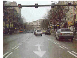
Marcas longitudinales discontinuas dobles.
